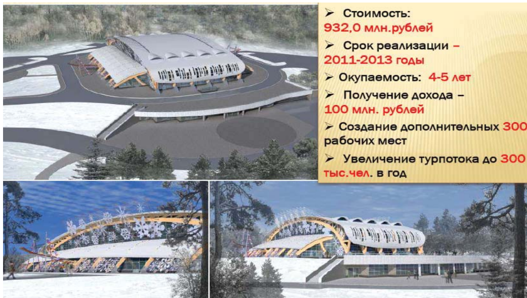
Рис. 7. Строительство Ледового дворца в г. Великом Устюге
